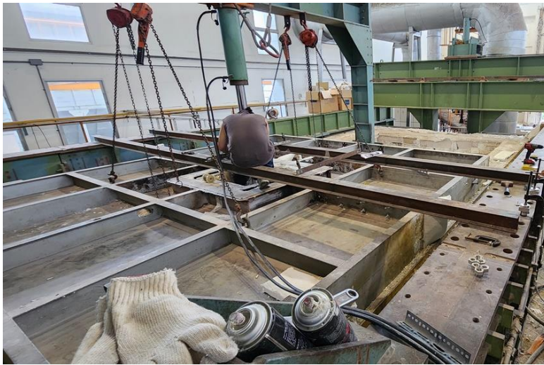
圖3-19 柱爐上方爐蓋開口處作業情形
