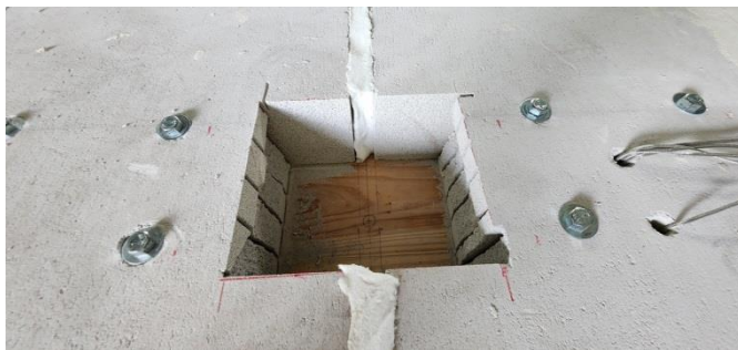
圖 3-15 輕質混凝土樓板供千斤頂在梁上方施力開口
