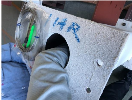
圖 3-12 鋼管柱安裝電熱偶情形
