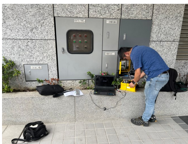
圖 4-8 智慧監控系統流量計數據控制器維護修繕 (資料來源：本研究團隊拍攝)
