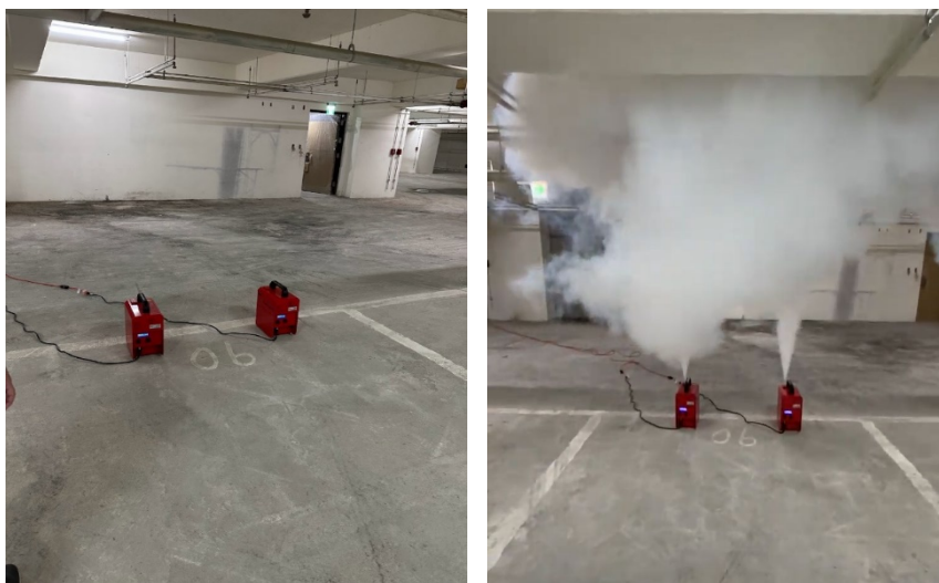
圖 3-75 消防演練煙霧機_實機操作煙霧產生效果
