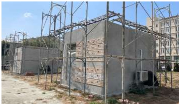
圖 5-12 全尺度實驗屋建造之外觀 (資料來源：本研究製作)
