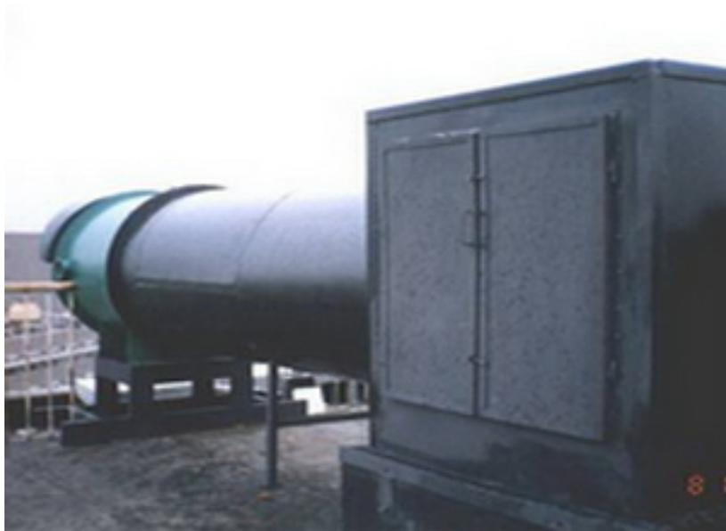
圖 2-36 機械排煙系統外觀
