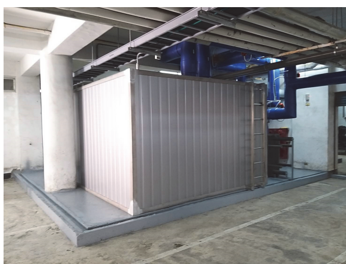
圖 3-14 國立 PGH 學校儲冰空調系統完工之情形 (非本計畫內執行成果，僅提供參考需完成計畫之前置作業)
