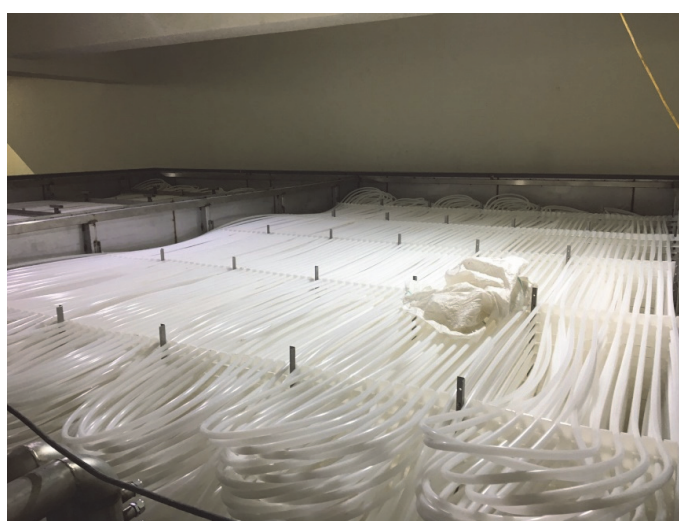
圖 3-12 國立 PGH 學校儲冰槽內部施工之情形 (非本計畫內執行成果，僅提供參考需完成計畫之前置作業)
