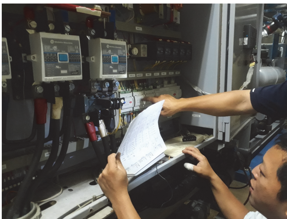
圖 4-7 G 醫院冰水主機硬體方面之修改與精進--- 現場電機線路修改(1)
