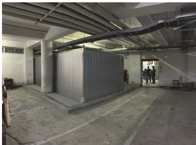
圖 3-13 國立 PGH 學校儲冰槽完工之情形 (非本計畫內執行成果，僅提供參考需完成計畫之前置作業)
