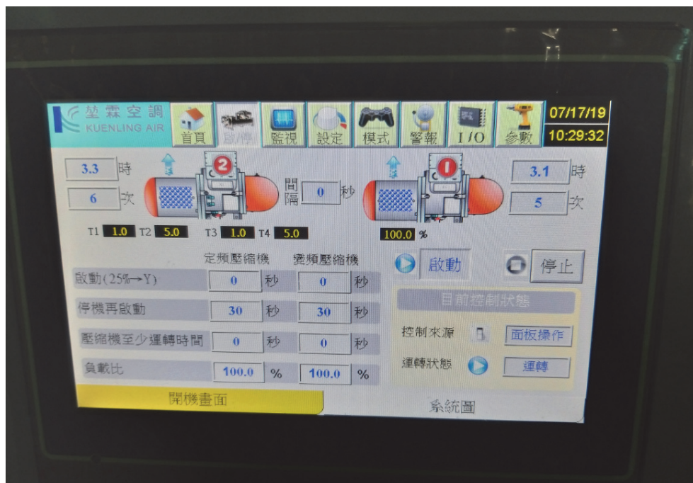
圖 4-1 冰水主機側控制邏輯之修改
