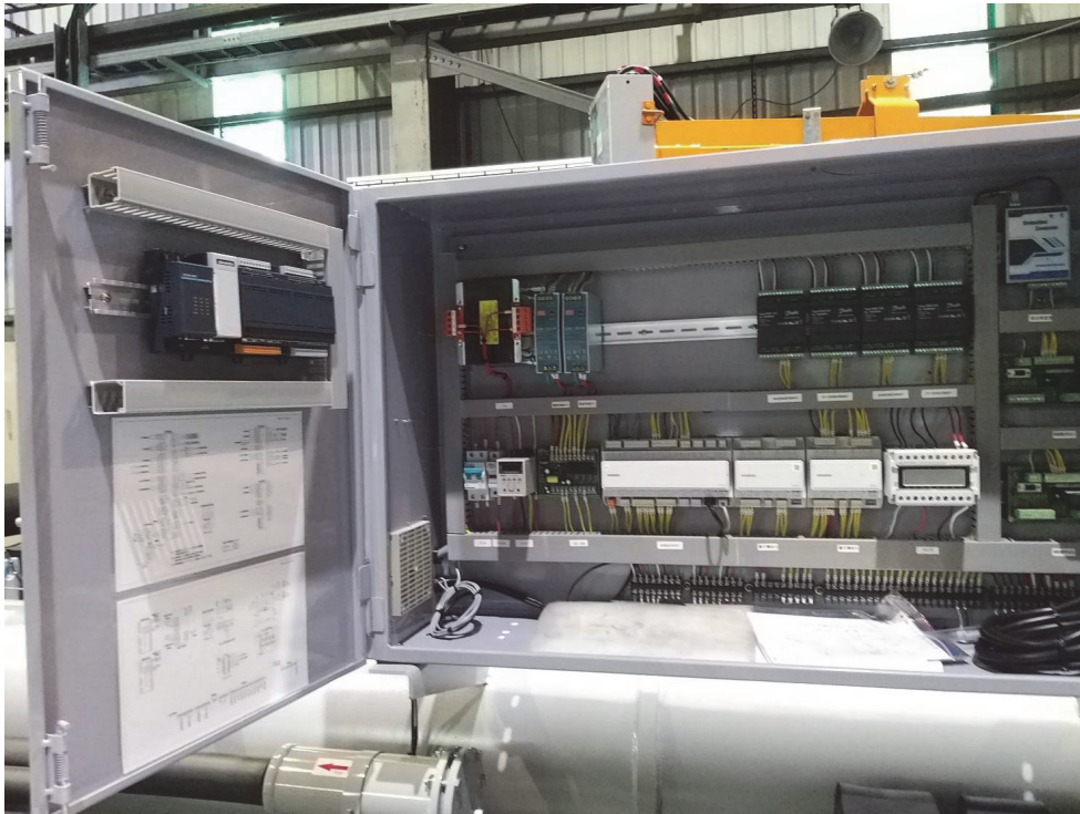
圖 4-8 G 醫院冰水主機硬體方面之修改與精進--- 現場電機線路修改(2)
