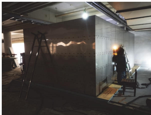
圖 3-11 國立 PGH 學校儲冰槽外部立板施工之情形 (非本計畫內執行成果，僅提供參考需完成計畫之前置作業)
