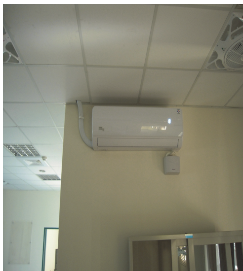
圖 2-1 某 C 縣政府衛生局之氣冷分離式空調系統
