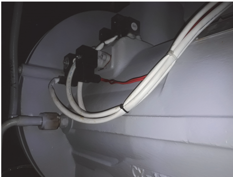
圖 4-5 G 醫院冰水主機硬體方面之修改與精進--- SV 閥安裝完成的情形(1)
