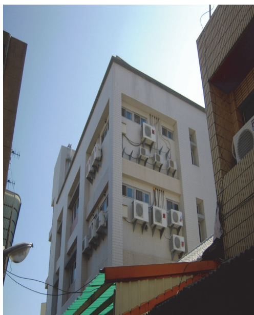
圖 2-1 某 C 縣政府衛生局之氣冷分離式空調系統
