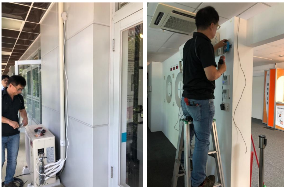
圖 3-9 小型建築空調系統結合 IoT 物聯網之施工佈線情形 (資料來源：本研究整理)
