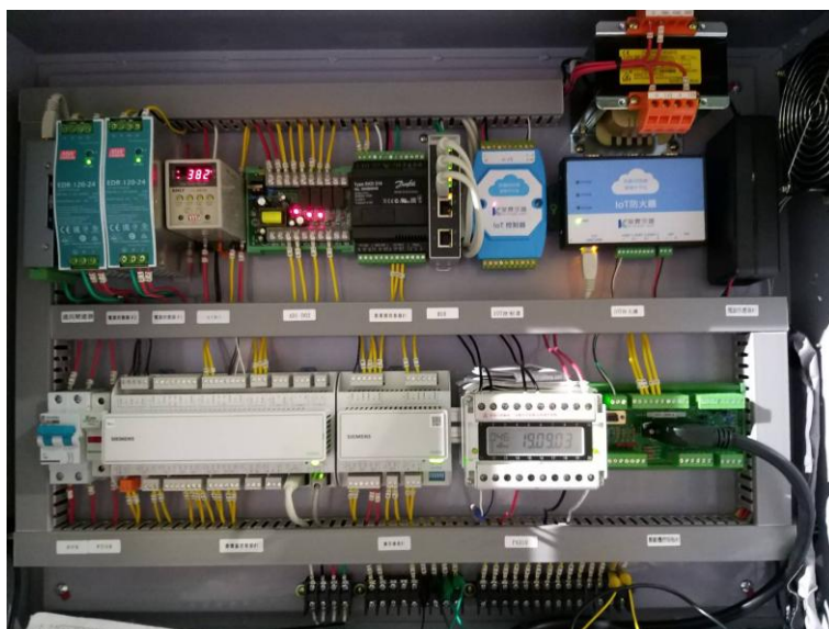
圖 3-4 大型建築空調主機系統結合 IoT 設計之系統硬體裝置情形 (資料來源：本研究整理)
