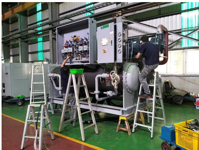
圖 3-4 大型建築空調主機系統結合 IoT 設計之系統硬體裝置情形 (資料來源：本研究整理)
