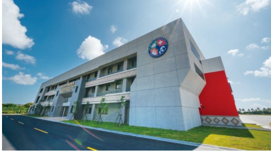
臺東駐地興建工程
