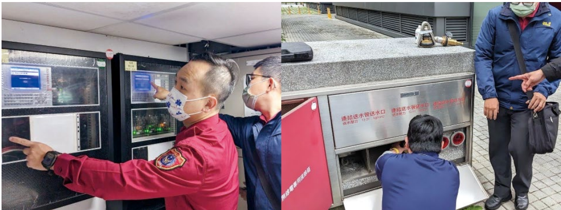
消防機關執行消防安全設備檢查
