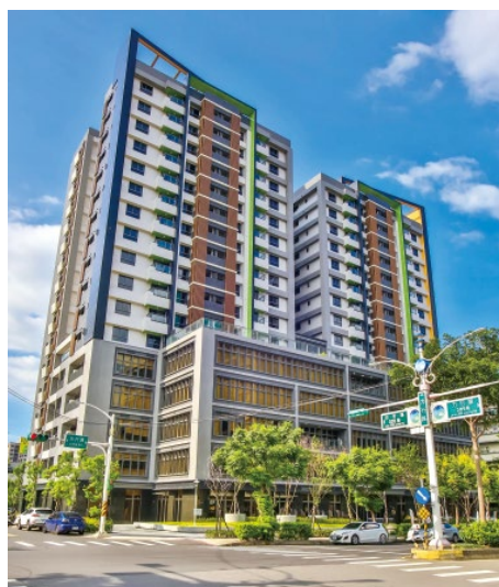
優良智慧建築得獎作品-桃園市桃園區中路二號基地新建公營住宅統包工程
