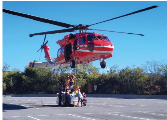
支援營建署興建山屋建材吊掛作業
