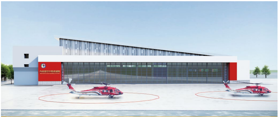
臺東駐地直升機棚廠興建工程
