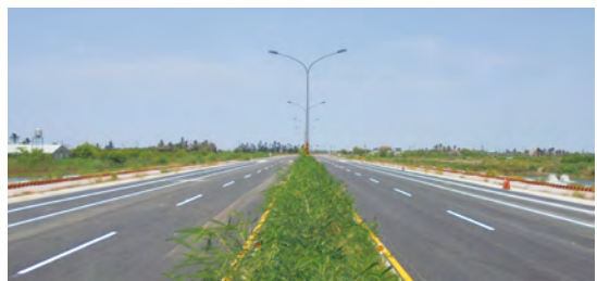
臺南市2-7道路西段工程
