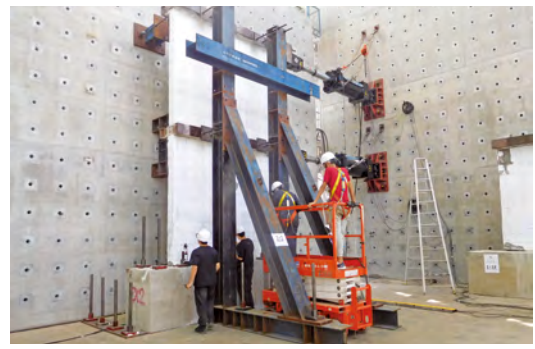
多單元鋼管鋼網牆之加載試驗
