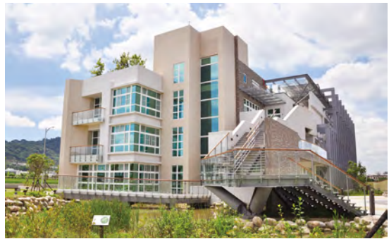
臺中市豐原水資源回收中心正式營運
