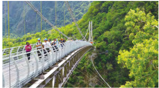
山月吊橋開放情形
