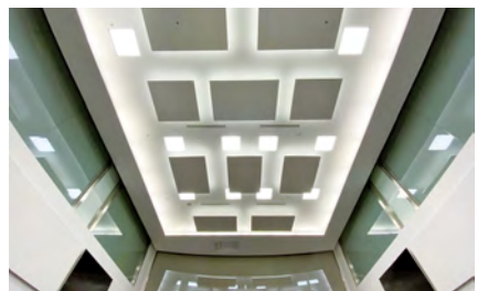
中央災害應變中心更新工程
