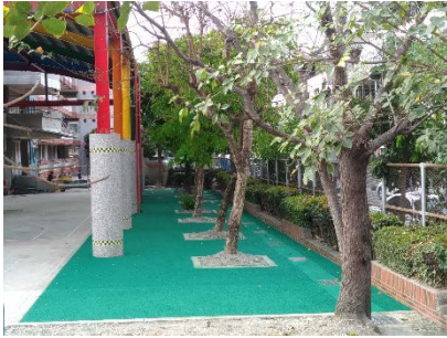
圖 7-7 現場整體澆置之剛性透水鋪面
